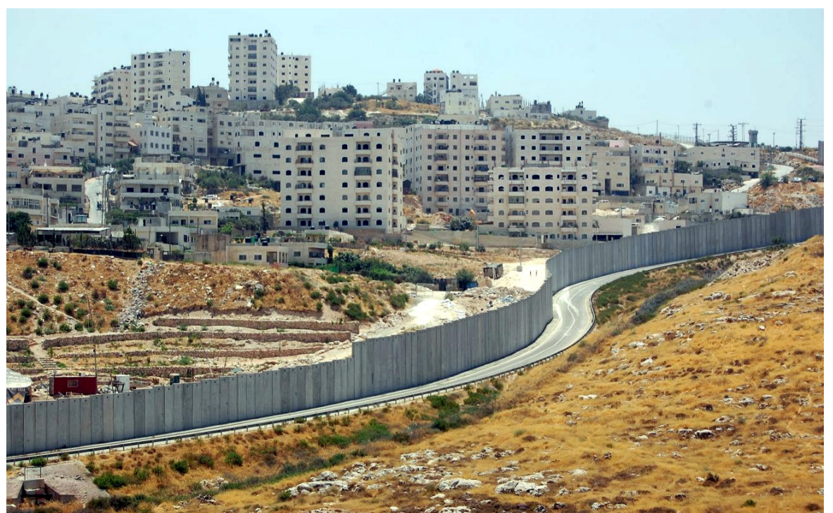
Cemex está contribuyendo a la construcción de un muro de Apartheid en Palestina. Foto tomada de palestinalibre.org
